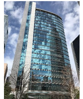
(新幸橋ビル外観)
